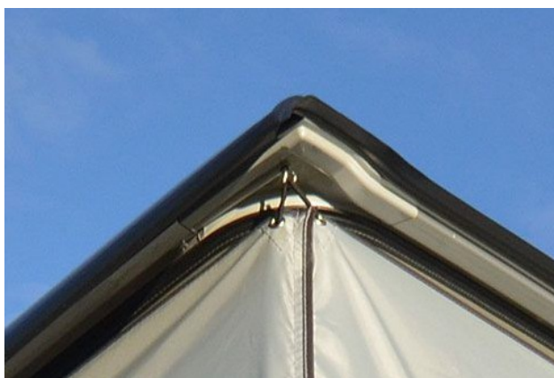
Image 10 - Accrochage du Calitop au toit. (Vue du coin avant droit du toit).
